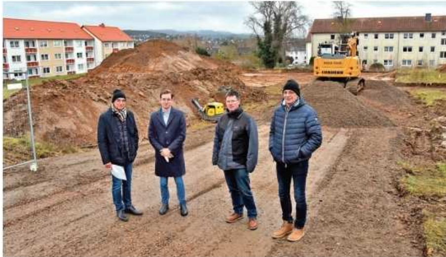
Kenneth und Dave Woods sowie planer Holger Neubert und Bauleiter Rüdiger Otto freuen sich, dass die Arbeiten an der Hochstraße endlich begonnen haben.
