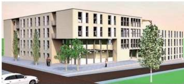
Vier Etagen, heller Eingangsbereich und große Dachterasse, so sieht die Pflegeeinrichtung aus.
